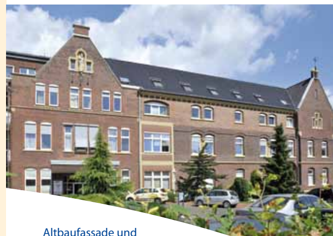
Altbaufassade und Bettentrakt sind bereits modernisiert.
